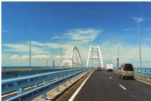
Мост через Керченский пролив
