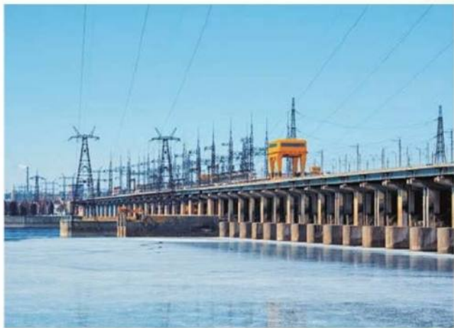
Плотина Волжской ГЭС
